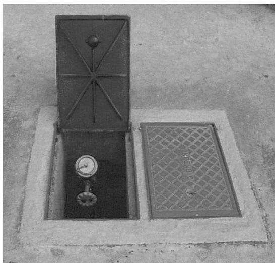
**Figura 64** - Registro de recalque para bombeiros
