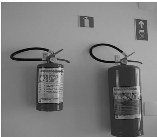
**Figura 9** - Extintor de incêndio
