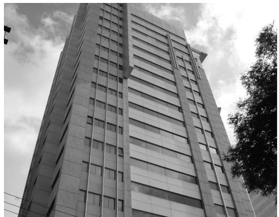
**Figura 10** - Compartimentação vertical de fachada
