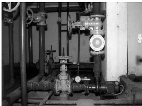
**Figura 66** - Bomba de incêndio e acessórios hidráulicos
