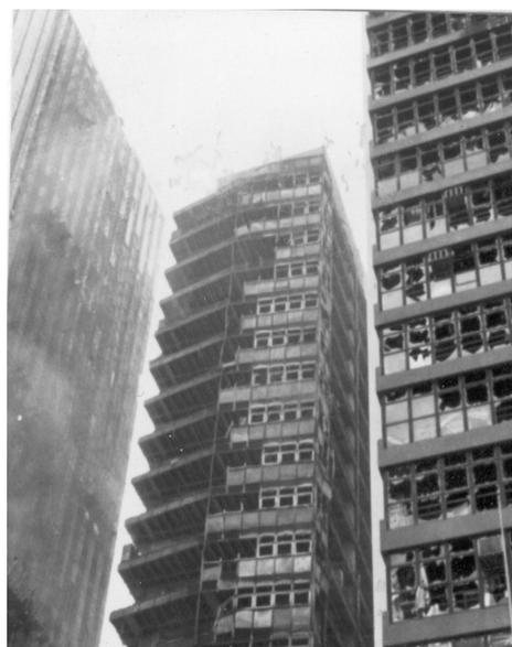
**Figura 16** - Propagação entre blocos
