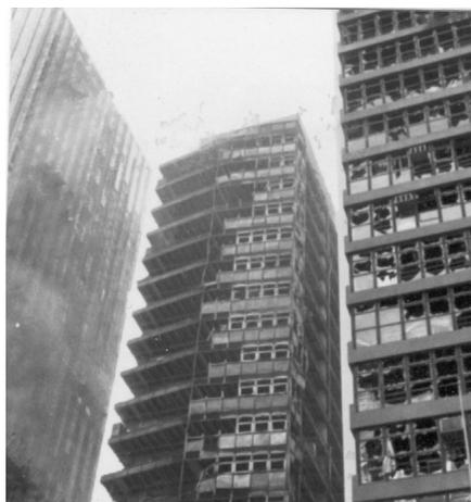
Figura 24 - Radiação de calor de um edifício para outro
